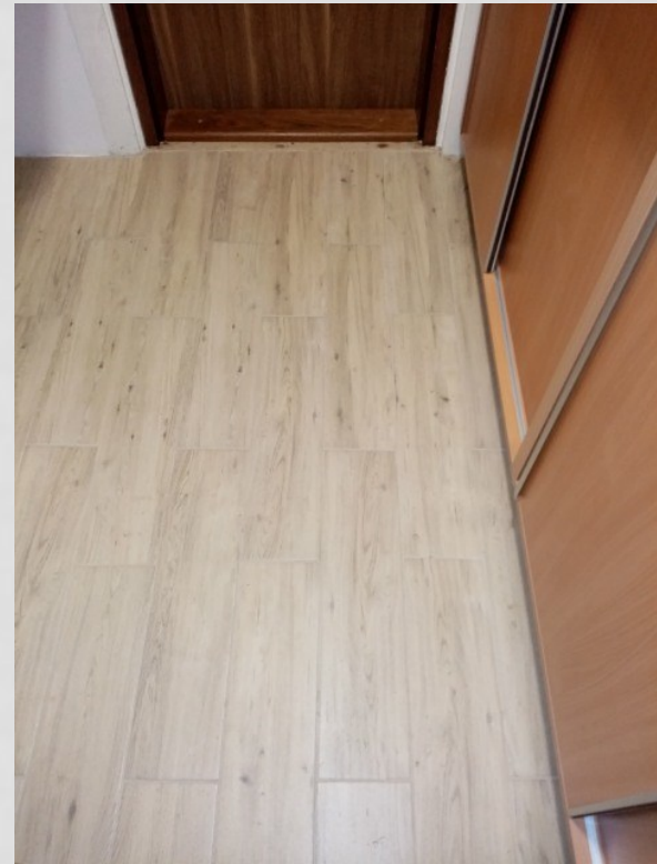
Podlaha – po rekonštrukcii
