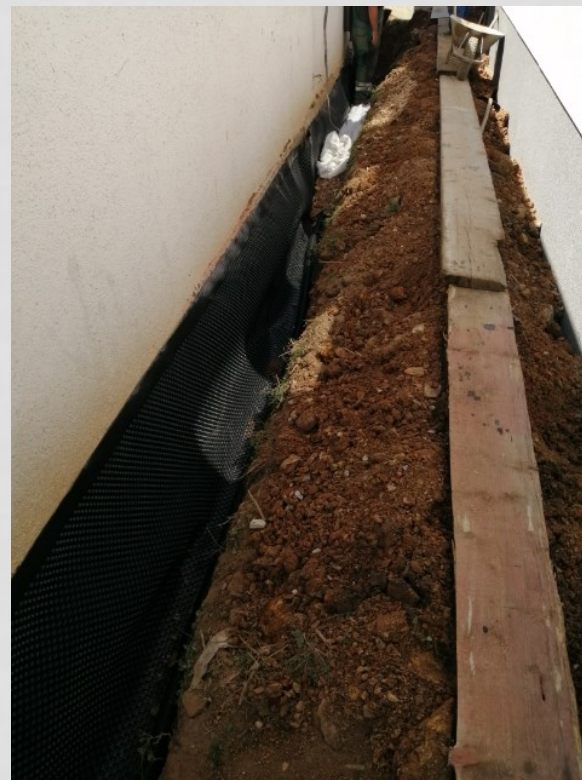
Položenie kanalizácie a drenáž steny OcÚ
