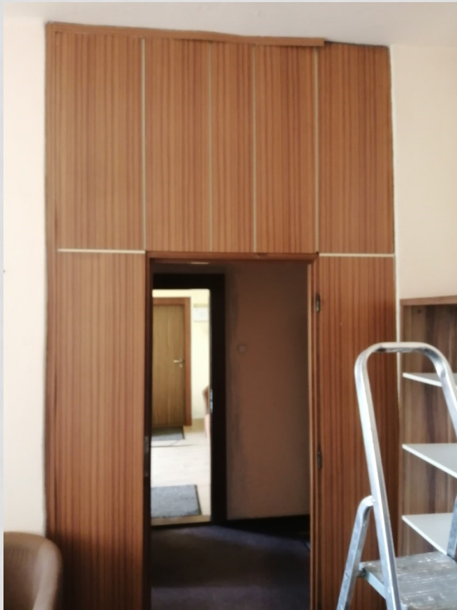
Vstup do kancelárií pôvodný stav
