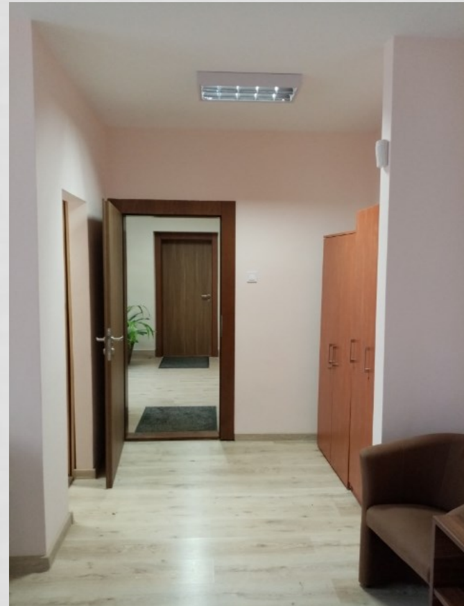
Vstup do kancelárií po rekonštrukcii
